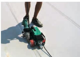
Perfekte Schweißnaht-Qualität trotz geringem Eigengewicht. Garantiert faltenfreies Schweißen einer Schweißnaht von 40 mm breite durch eine raffiniert Technologie.
